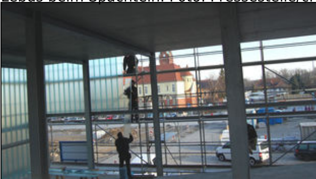
Christopher Schrape von der Baufirma keb aus Lebus beim Spachteln. Foto: Pressestelle/cf (Bild: 2/3)
